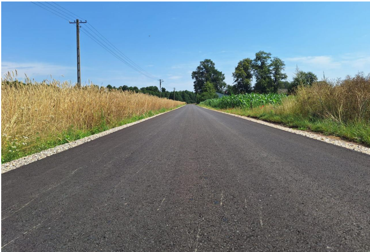
3) Remont drogi w miejscowości Jeżów ul. Leśna,
