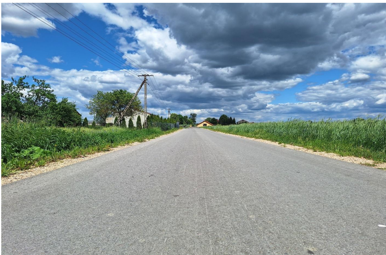
6) Remont drogi przez miejscowość Rewica Szlachecka,
