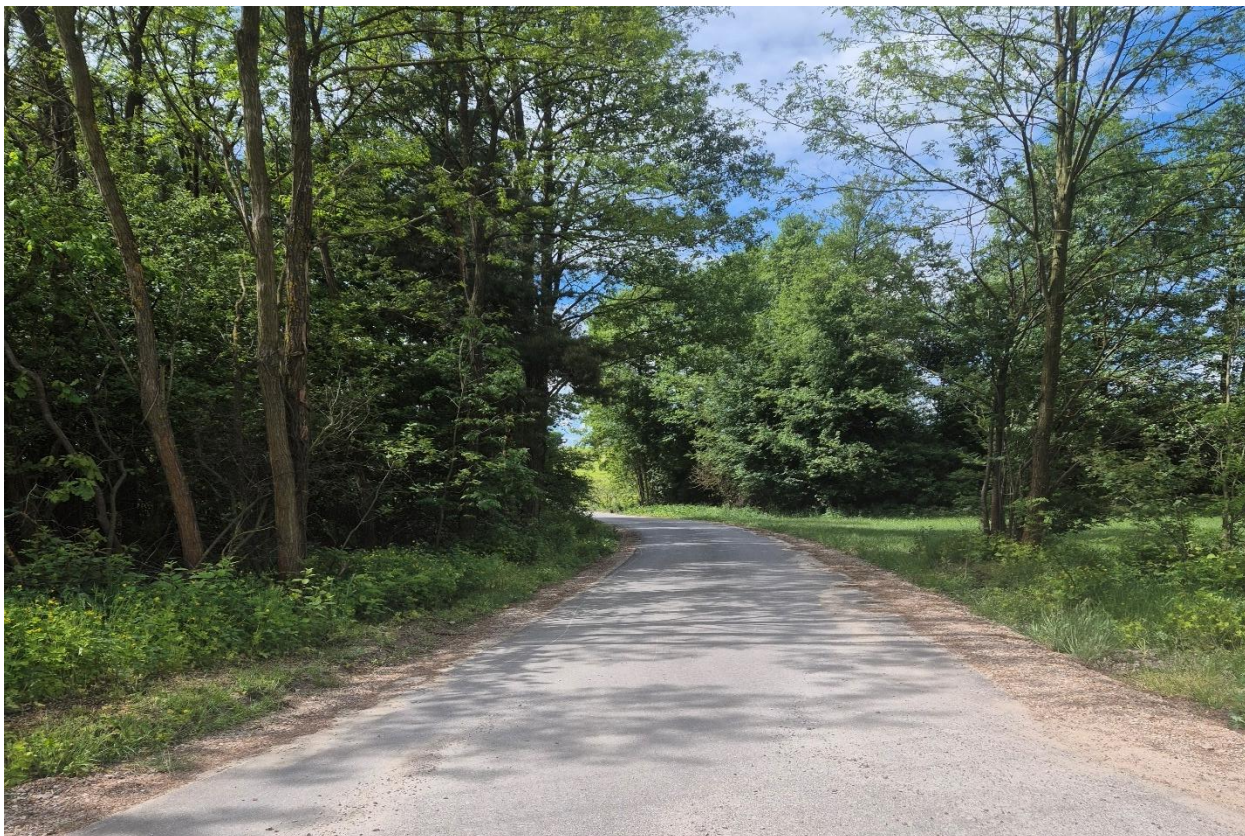
7) Remont drogi na odcinku Przybyszyce „Niwa” w kierunku do ul. Łąkowej w Jeżowie,
