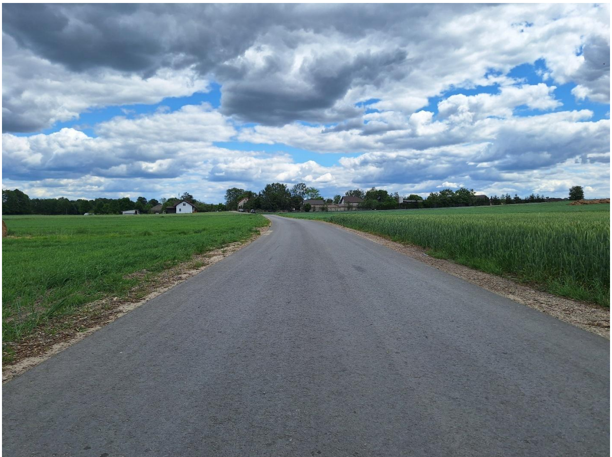
2) Remont drogi w miejscowości Wola Łokotowa na odcinku od DP2920E przez działkę o numerze ewidencyjnym 200 i część działki o numerze ewidencyjnym nr 189, obręb Wola Łokotowa,
