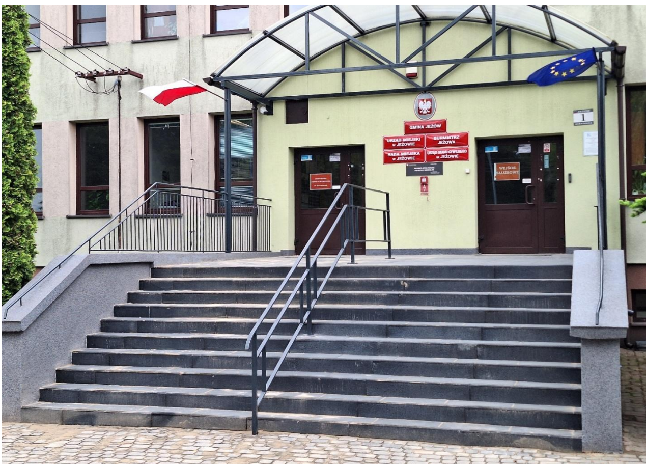
Zdjęcie 7. Schody Urzędu Miejskiego po remoncie. Źródło: materiały własne
