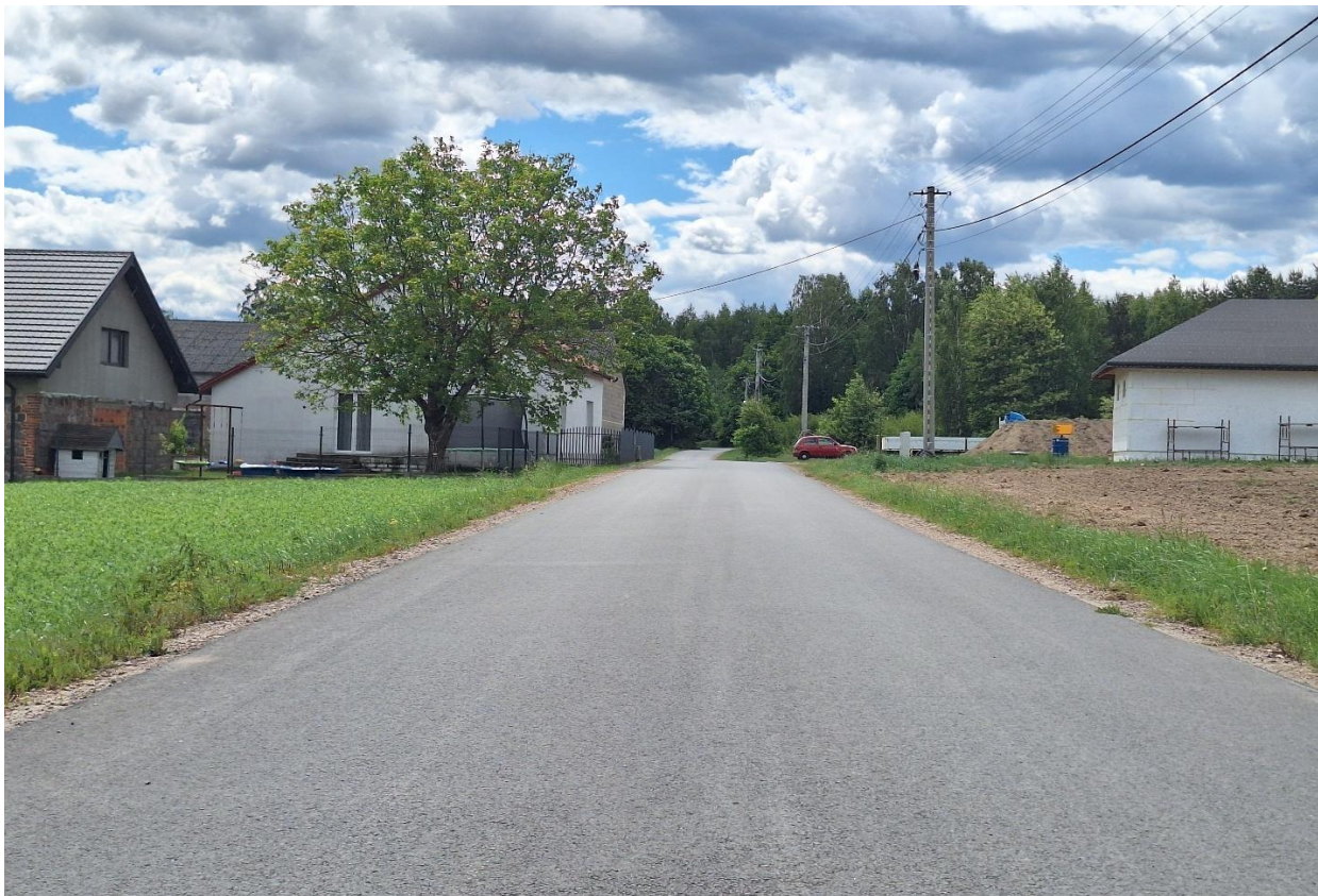
5) Przebudowa drogi w miejscowości Brynica – Taurów; etap II,
