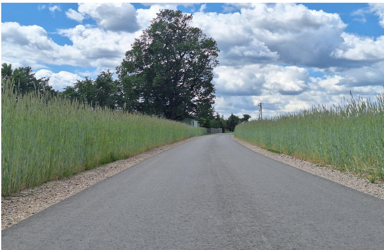
4) Remont drogi w miejscowości Jankowice na odcinku od drogi gminnej nr 121108E do granicy z gminą Głuchów,
