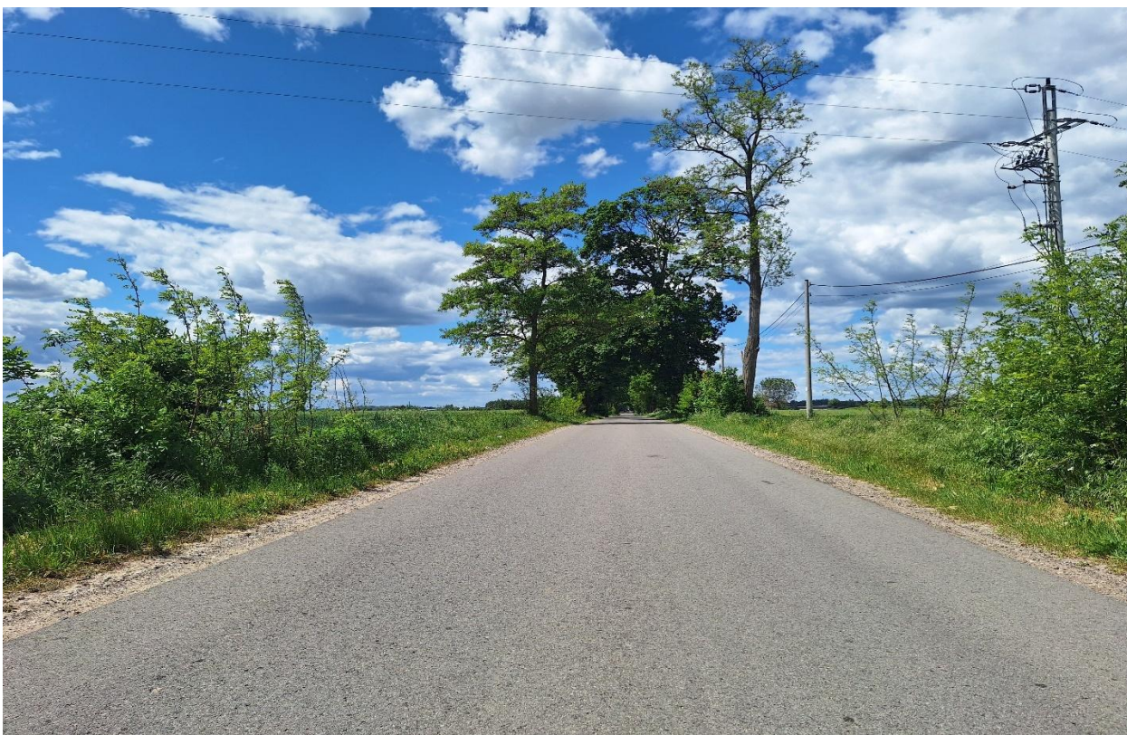
8) Remont drogi w miejscowości Dąbrowa.
