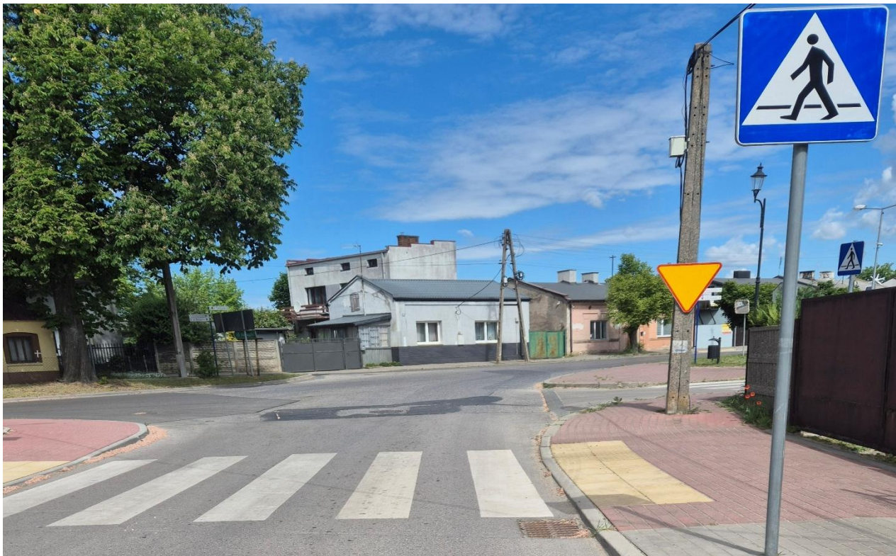
Zdjęcie 21. Przejście dla pieszych ul. Górna w Jeżowie. Źródło: materiały własne
