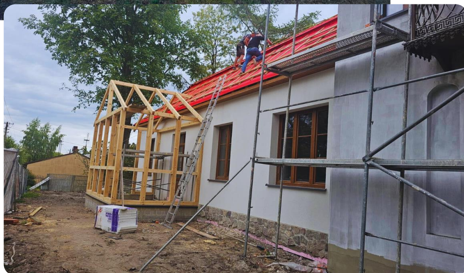
Od góry Zdjęcie 17: Budynek po rozpoczęciu robót. Zdjęcie 18: Stan obecny robót. Źródło: materiały własne.
