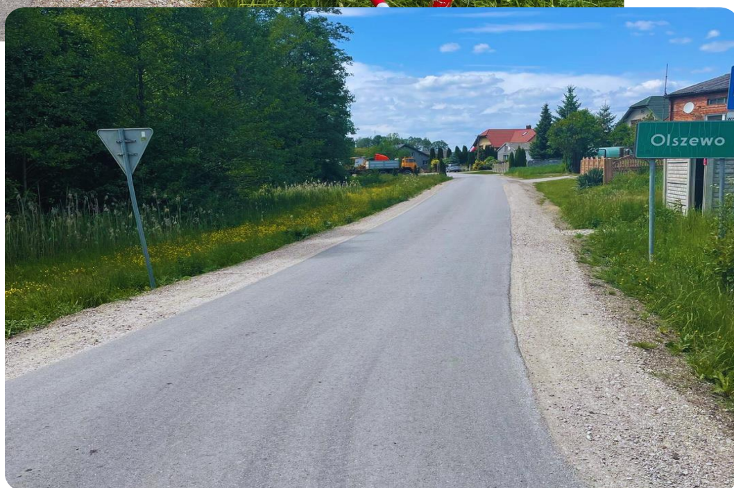
Zdjęcie 9: Wyremontowana droga w miejscowości Władysławowo. Zdjęcie 10: Wyremontowana droga w miejscowości Olszewo. Źródło: materiały własne.
