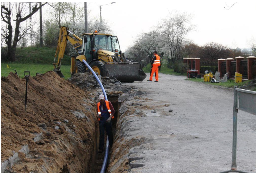
Zdjęcie 8: Roboty budowlane. Źródło: materiały własne.
